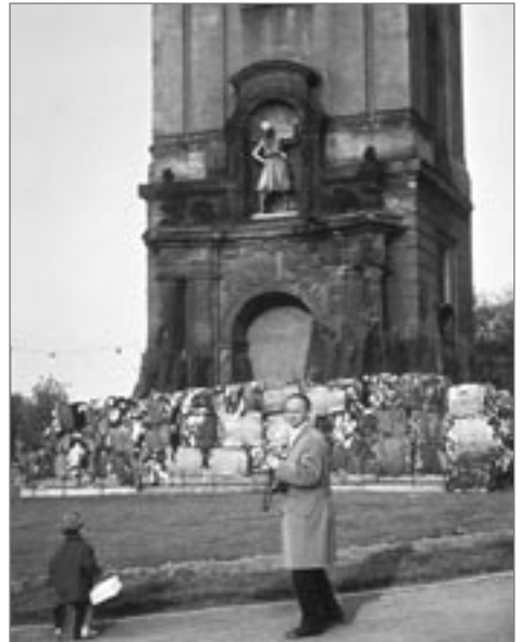
Johannes Schulze 1963 vor dem zur Sprengung vorbereiteten Johanniskirchturm
